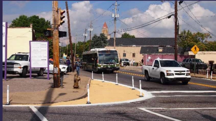
Ampliación de aceras en esquinas; Memphis, TN
