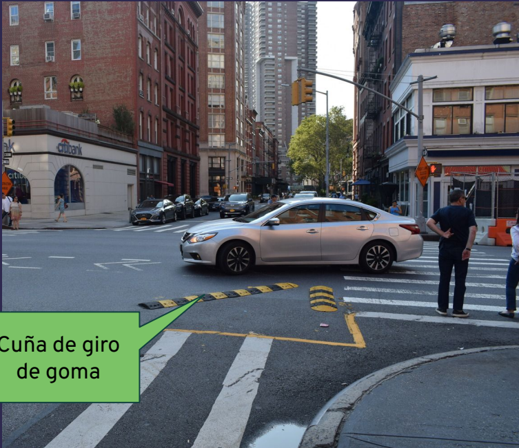
Reducción de los radios de las aceras con una "cuña de giro", NYC, NY
