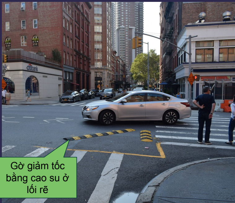
Giảm bán kính lề đường bằng “gờ giảm tốc ở lối rẽ”, NYC, NY
