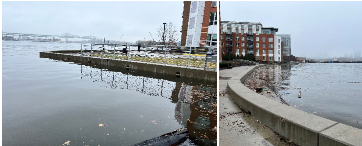
Figura 3. Las aguas de inundación alcanzaron los desagües de la escollera en los apartamentos Boston East, en el 126 de Border Street, durante enero de 2024. Si se hubiera combinado con un evento de marea alta extrema o unas pocas pulgadas más de lluvia, la altura de la escollera no habría bloqueado las aguas de la inundación. Weston & Sampson, 2024.
