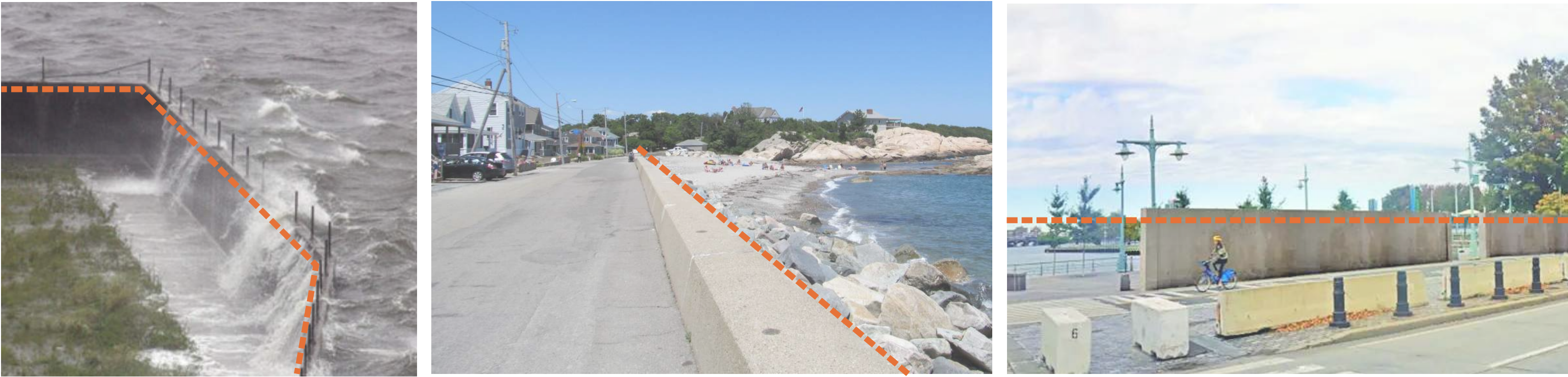
Typical flood wall Muro de contención típico
